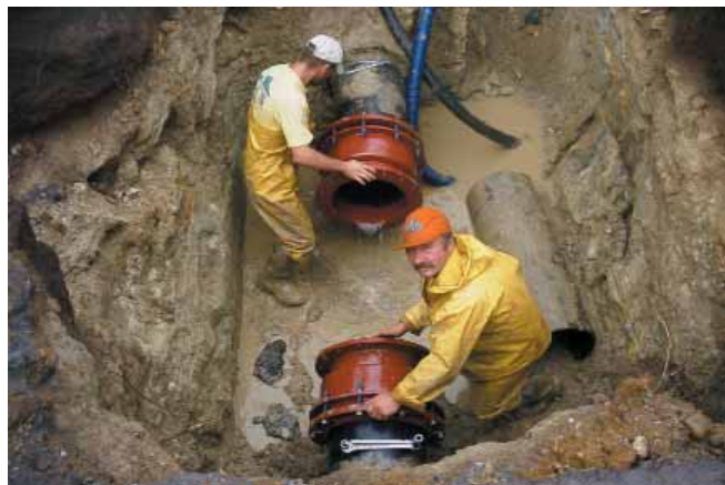
Рис. 4. Фитинги MULTI/JOINT можно использовать в самых неблагоприятных условиях монтажа.
